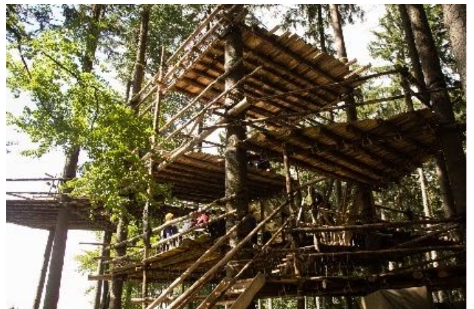
Ein fertiges Baumhaus mit Geländern. Foto: Deborah Loritz
